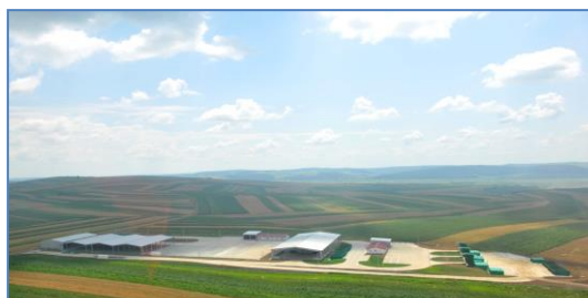
Instalația de tratare mecano-biologică Sînpaul
