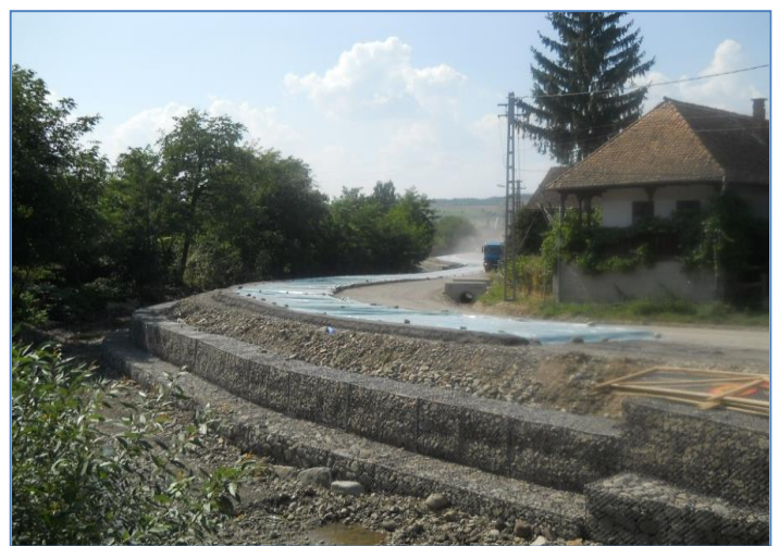
Consolidare cu gabioane
