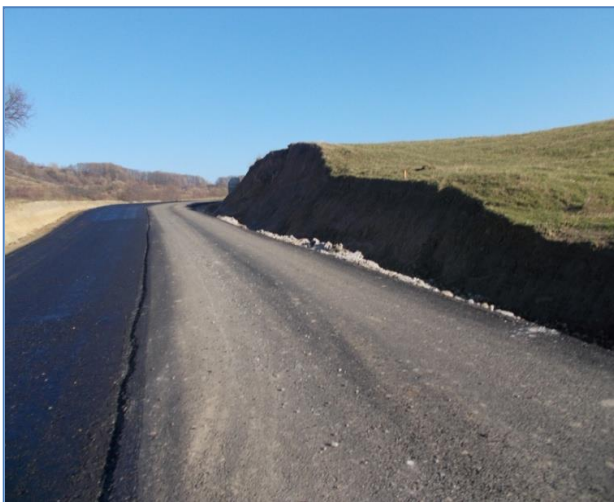
Strat de bază din mixtură asfaltică
