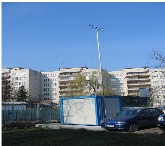
Stația de monitorizare a fondului urban e MS - 1
