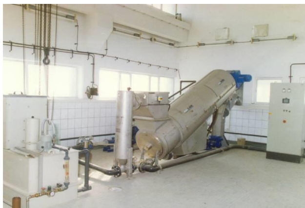
Figura Nr. 2-26 – Instalație mecanică de deshidratare
