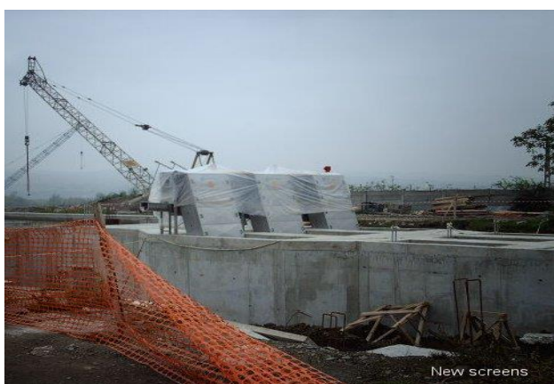
Figura Nr. 2-23 – Stația de tratare ape uzate – Gratare noi
