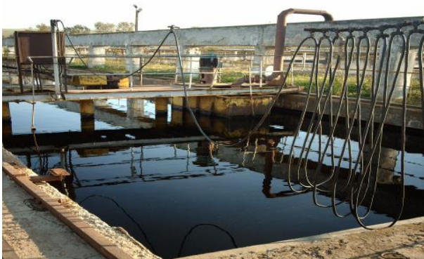
Figura Nr. 2-13 – Bazinul primar de sedimentare de sedimentare
