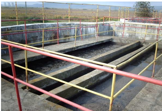
Figura Nr. 2-21 – Bazine de sedimentare canalizare
